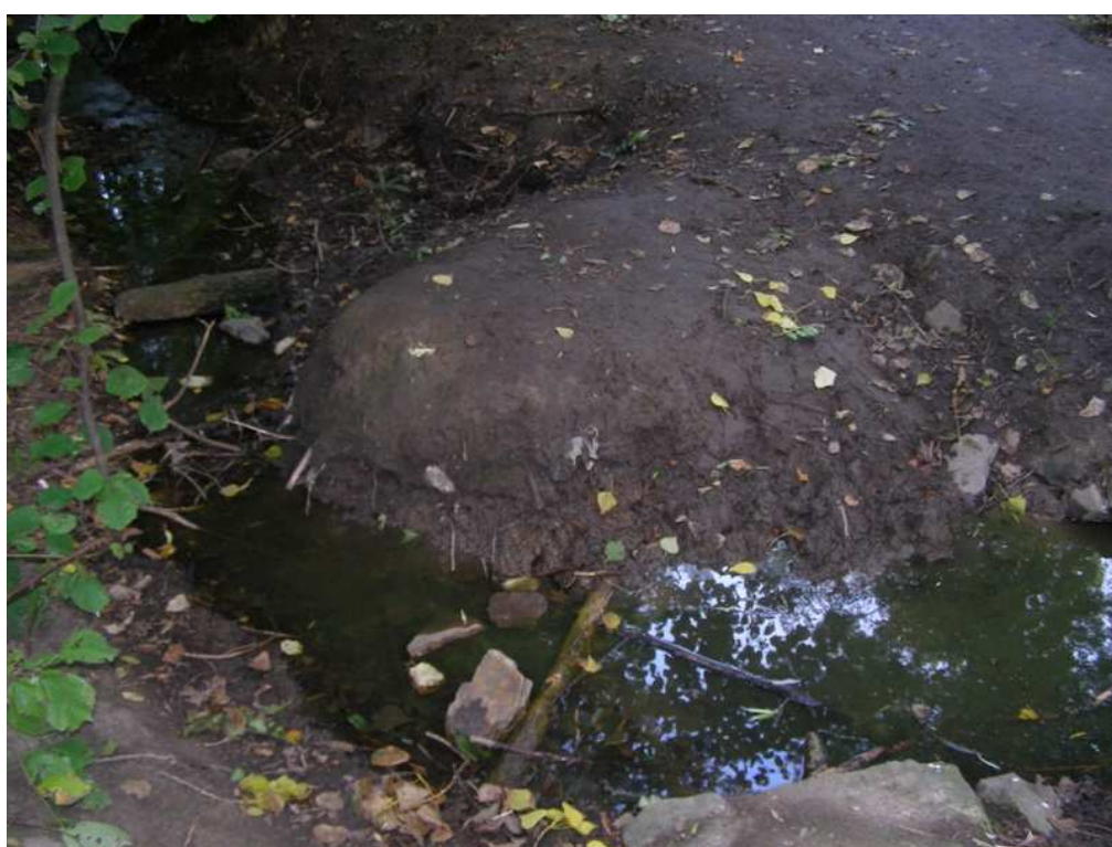
Plocha č. 5 – rozdělovací objekt před Litovickým rybníkem
